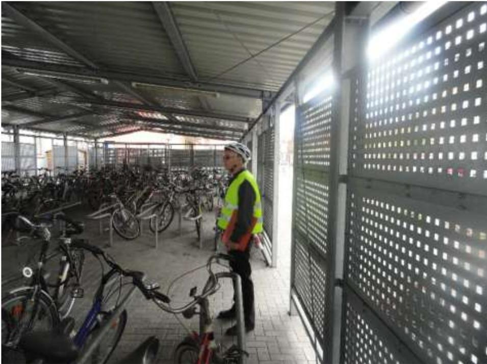
Die Einsicht von außen in den Abstellbereich ist durch die Metallblenden verbaut. Dies erhöht das Diebstahl – und Beschädigungsrisiko für die dort abgestellten Räder.
